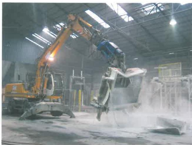
*Démolition de l'ancienne ligne d'ensacheuse qui est partie en ferraille*
